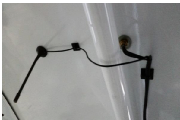
Bild 14: Montage WiFi-Antenne Dach-innenseite
