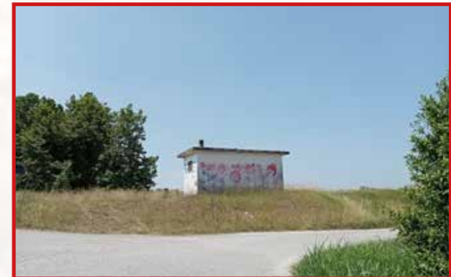
ARGINE SOLO A PIEDI DOPPIO PASSAGGIO
