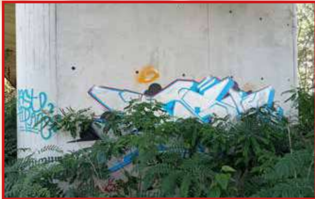
SOTTO PONTE CASARSA
